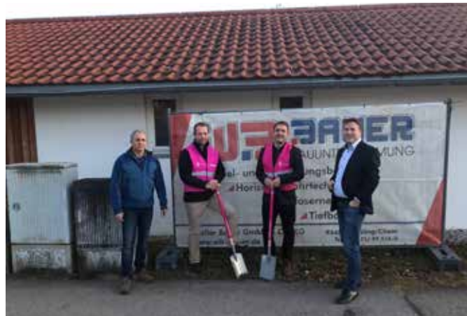
Foto: v.l. Helmut Aschenbrenner (Fa. Bauer), Klaus-Dieter Strauß (Teamleiter Technik Telekom), Jürgen Mayr (Breitbandbeauftragter Gem. Seeg) und Bürgermeister Markus Berkold.
