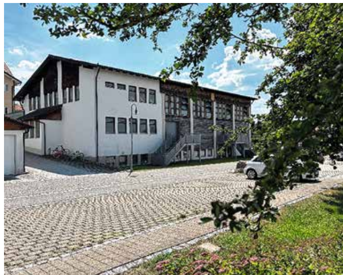
Schulturnhalle Lengenwang wird saniert.
