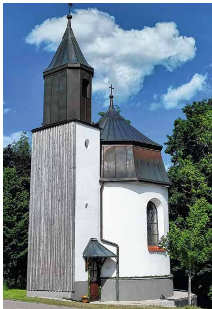
Die sanierte Kapelle von außen. – Foto: Theresia Rietzler
