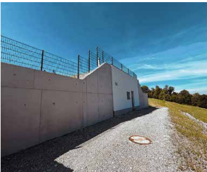
Der neue Wasserhochbehälter von Seeg. — Fotos: Gemeinde Seeg
