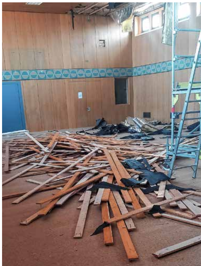
Abbau der Deckenverkleidung. – Foto: P. Hartl
