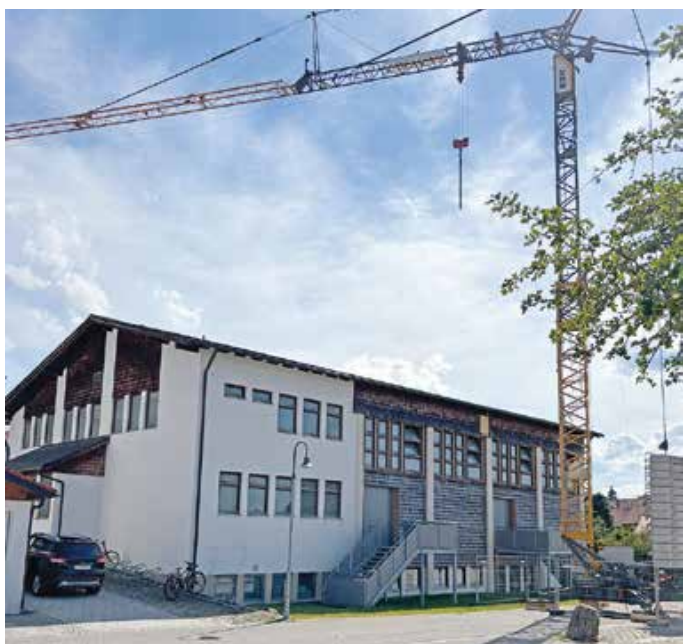
Der Baukran wurde bereits aufgestellt.
